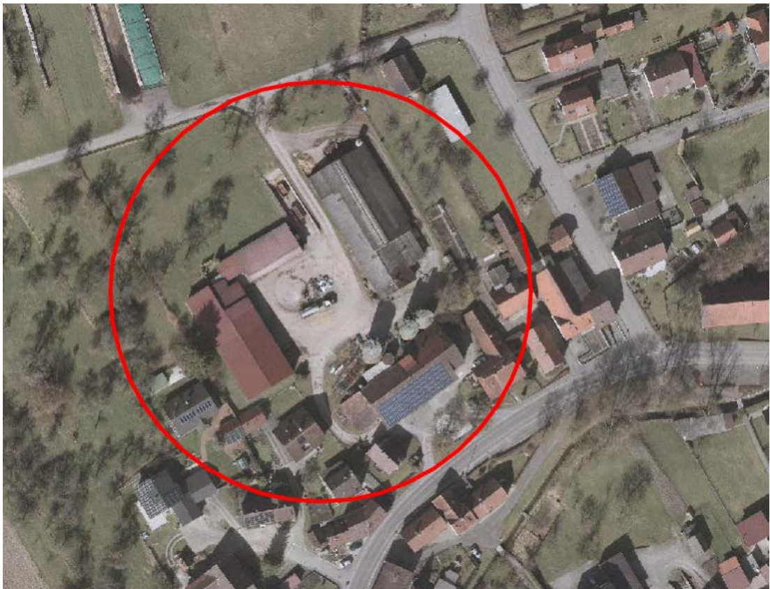
Luftbild des Plangebiets (vor Abriss der Hofstelle)
