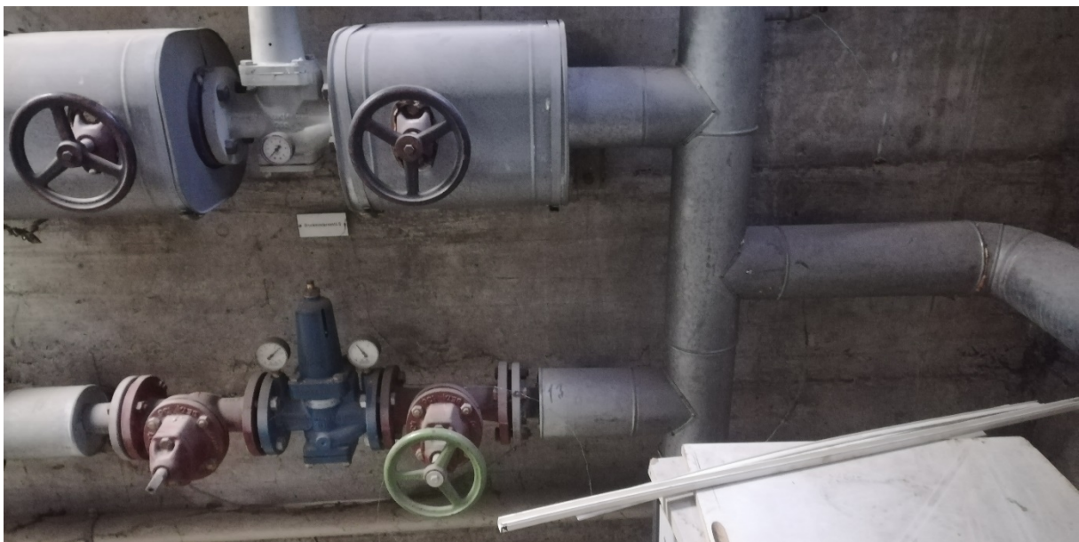
Doppelter Druckminderer mit Stagnationswasser
