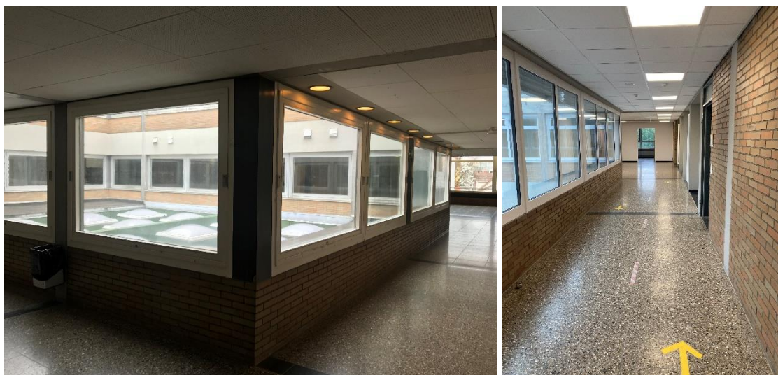
Fotos: Flur mit neuen Fenstern mit neuer Verschattung, Beleuchtung und Decke (vorher/nachher)
