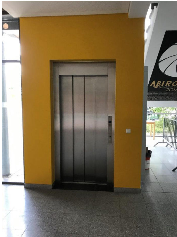
Fotos: nachher (Erneuerung Aufzug)
