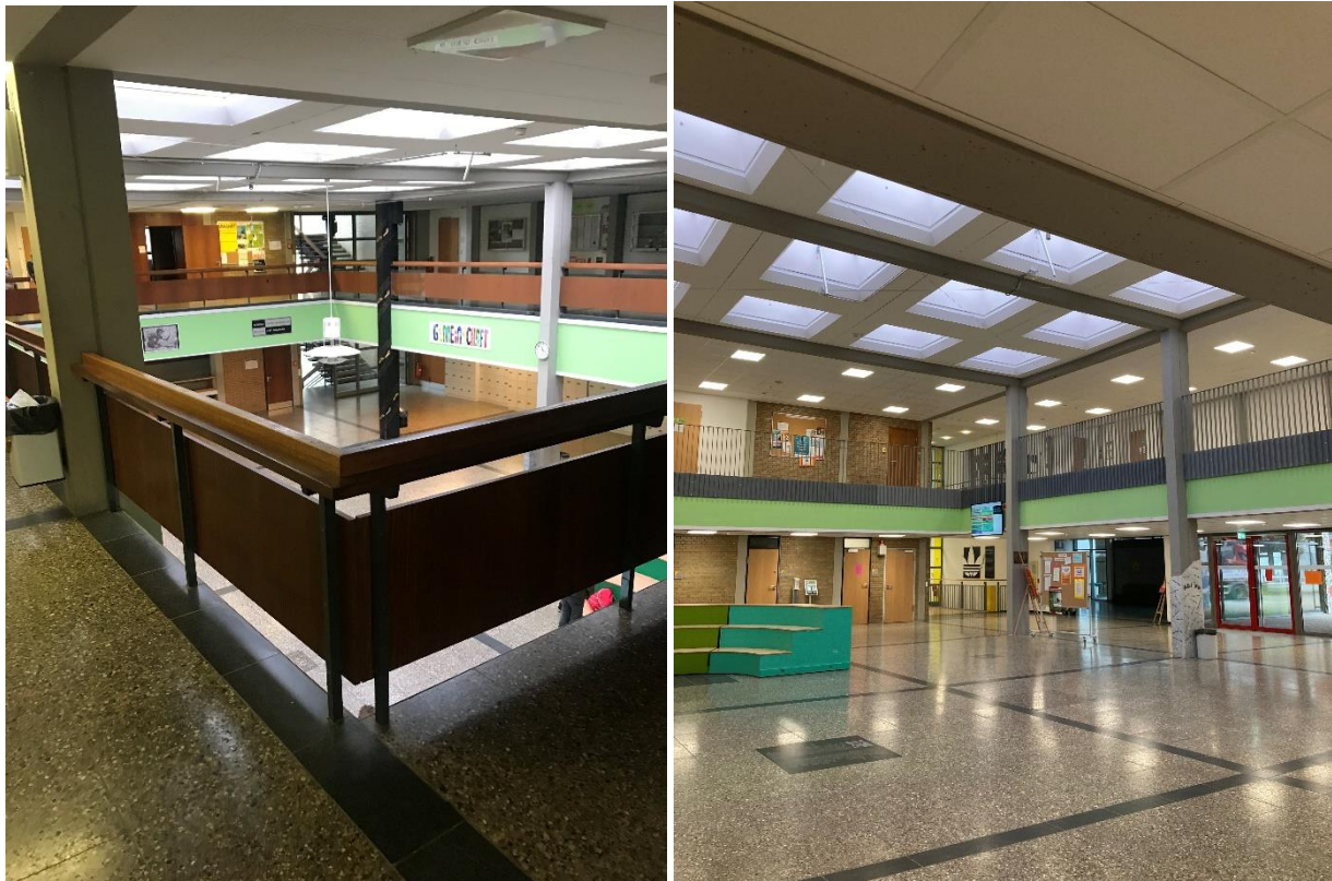
Fotos: Neue Brüstung im Atrium des Gebäudes (vorher/nachher)
