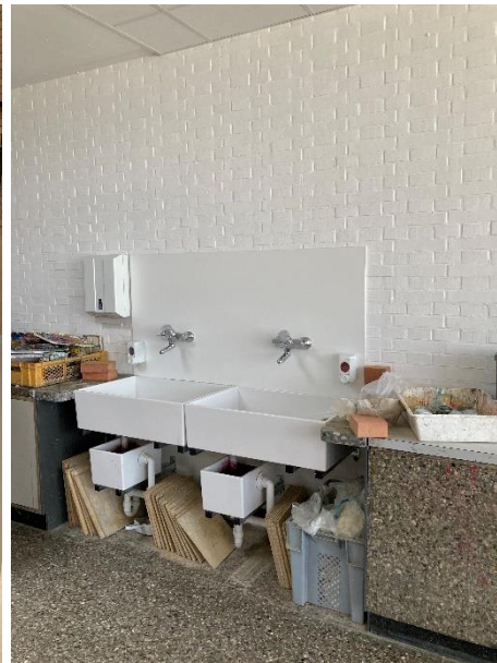
Fotos: Brennraum saniert; Tonabscheider im Werkraum
