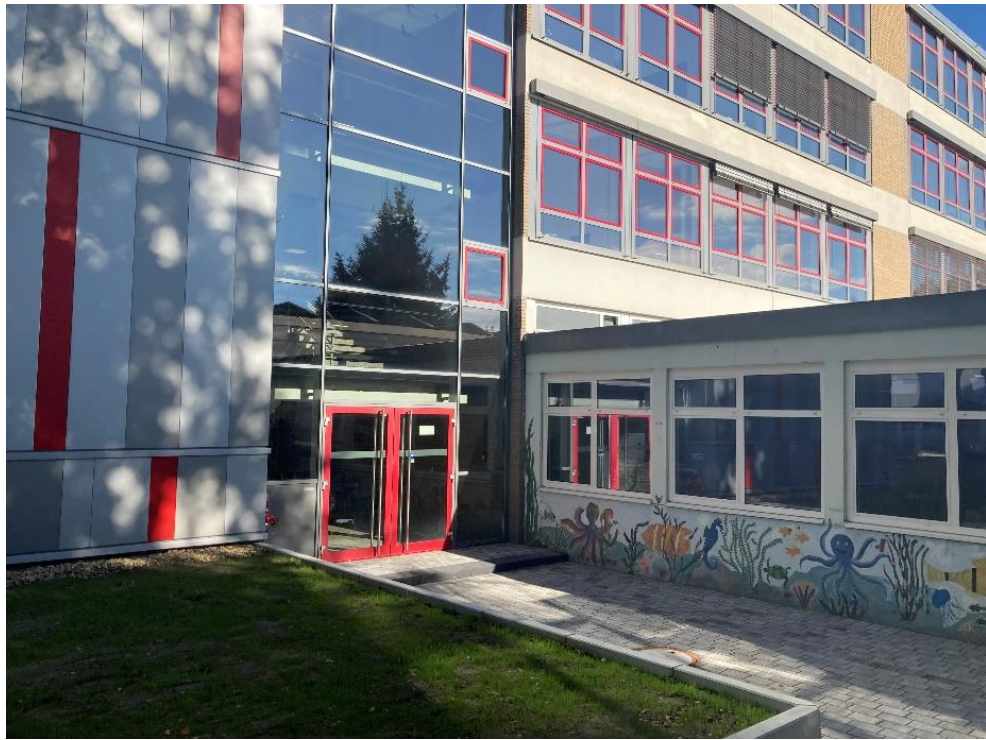
Foto: Tiefhof zum Schulhof, angeschlossen an Kanal
