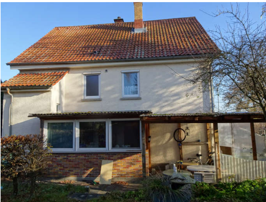
Abbildung 3: Wohngebäude Weldenstraße 59 aus Westen
