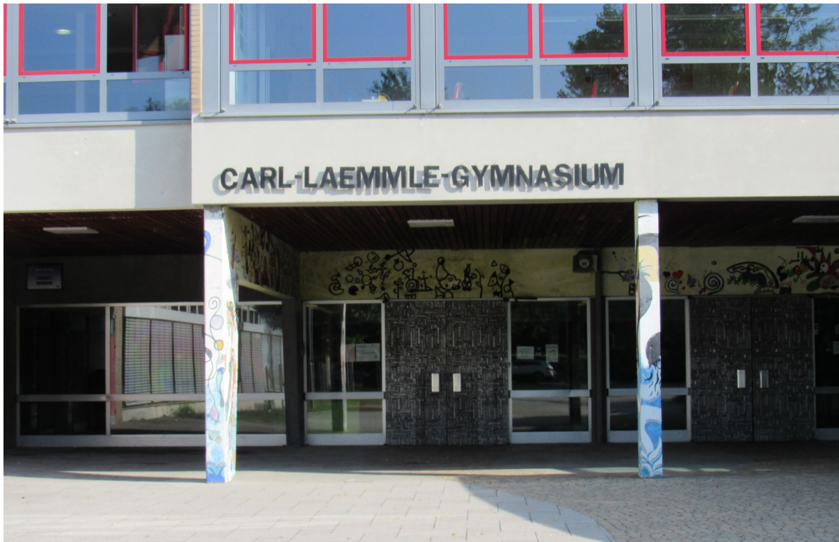
Bild 1: Eingang zum Hauptgebäude
