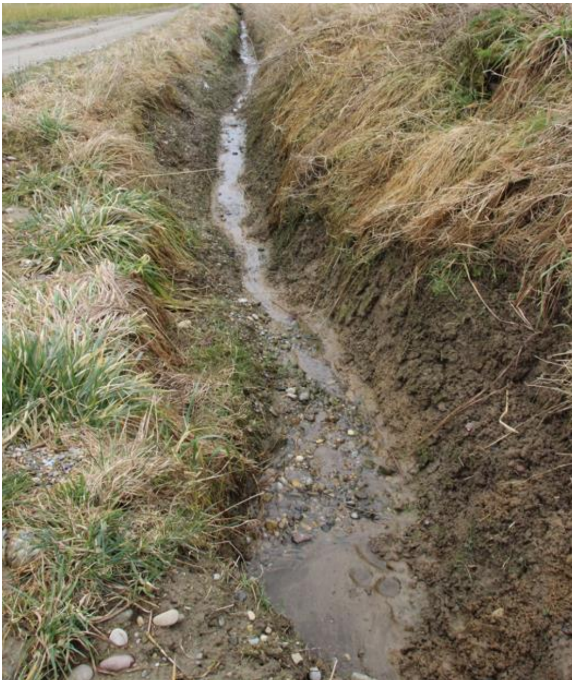
Abb. 2: Entwässerungskanal östlich des Geltungsbereiches
