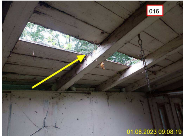
Foto: Fäulnis durch defekte Dachabdichtung im Boothaus
