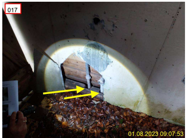
Foto: Schwelle stark geschwächte Schwelle, fäulnis durch Erdkontakt
