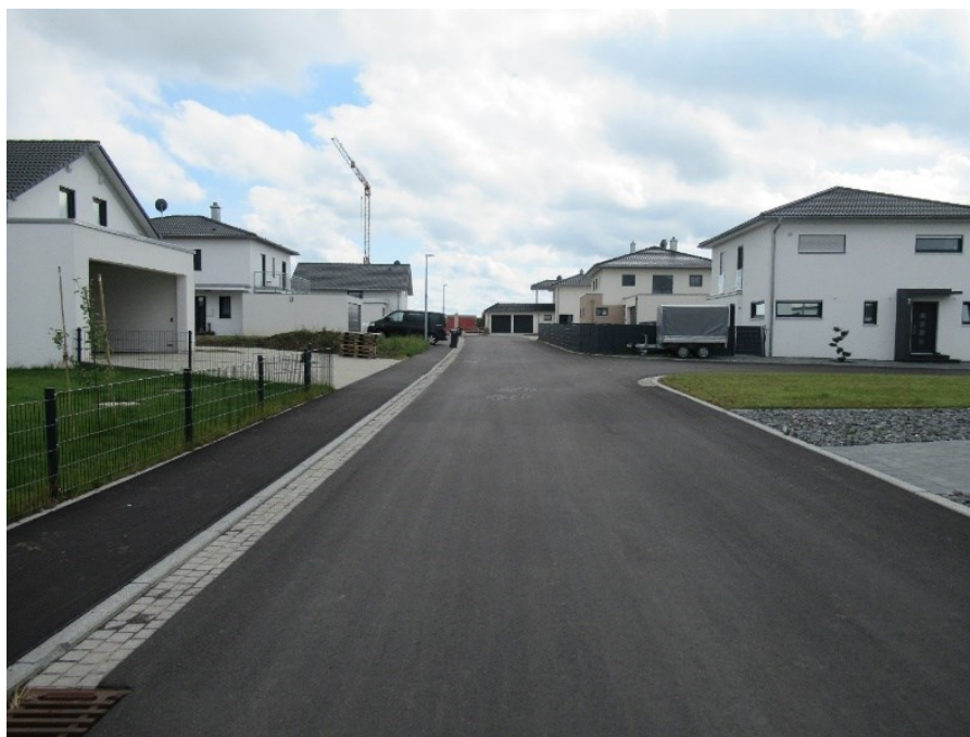
Straßenendausbau im Baugebiet Hirschenberg IV, 3. Bauabschnitt (2019)
