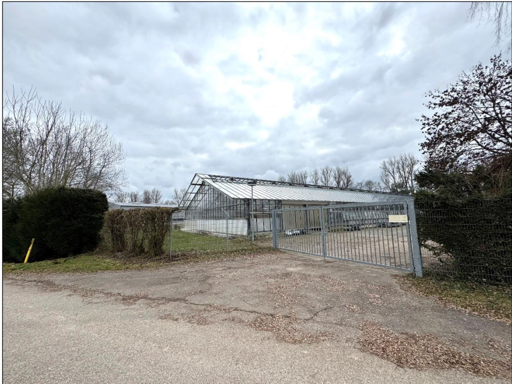
Gewächshaus zur Trocknung von Klärschlamm Außenansicht, 17.03.2025
