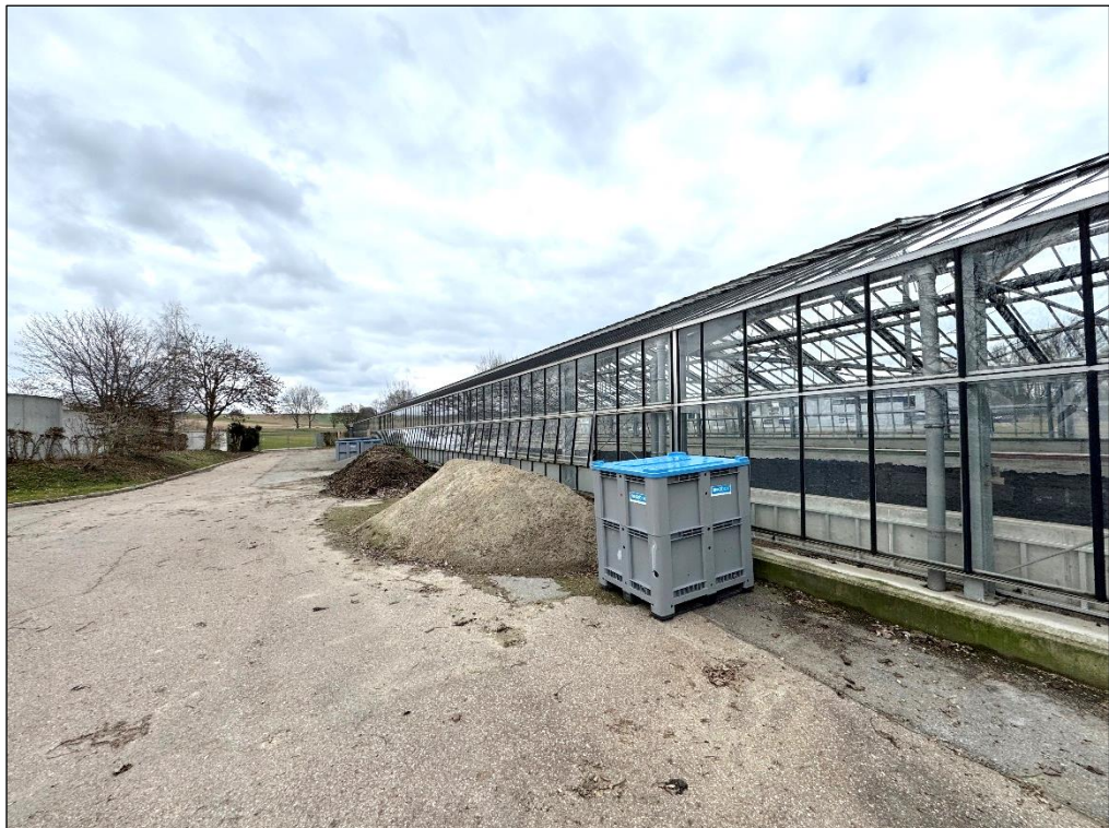
Gewächshaus zur Trocknung von Klärschlamm Außenansicht, 17.03.2025
