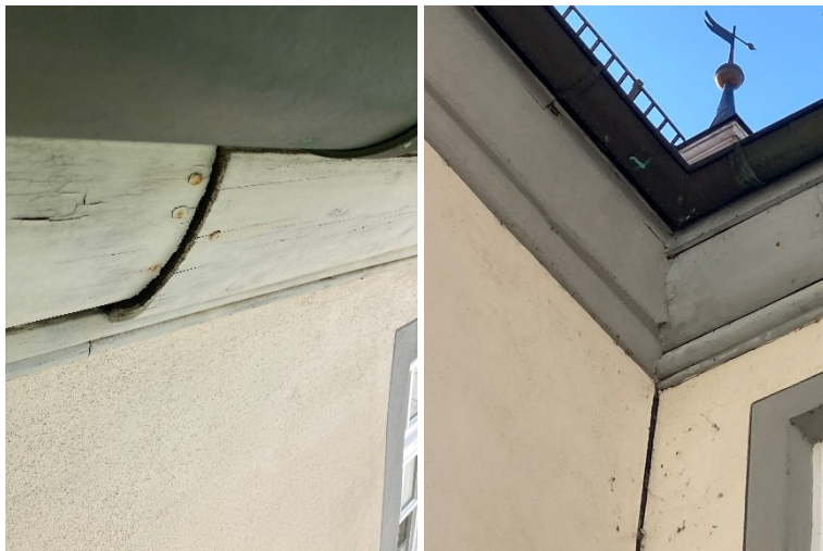
Bild: Lösen des Holzblenders im Dachbereich
